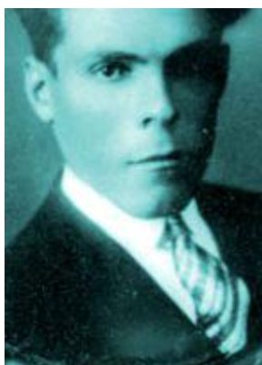
Figura 4. Arcangelo Tiziani era il custode della diga di Pontesei. Morì il 22 marzo sotto la frana della diga
