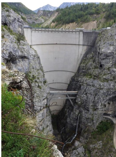
Figura 3. la diga del Vajont allo stato attuale Foto scattata dall'autrice il 6 ottobre 2013.
